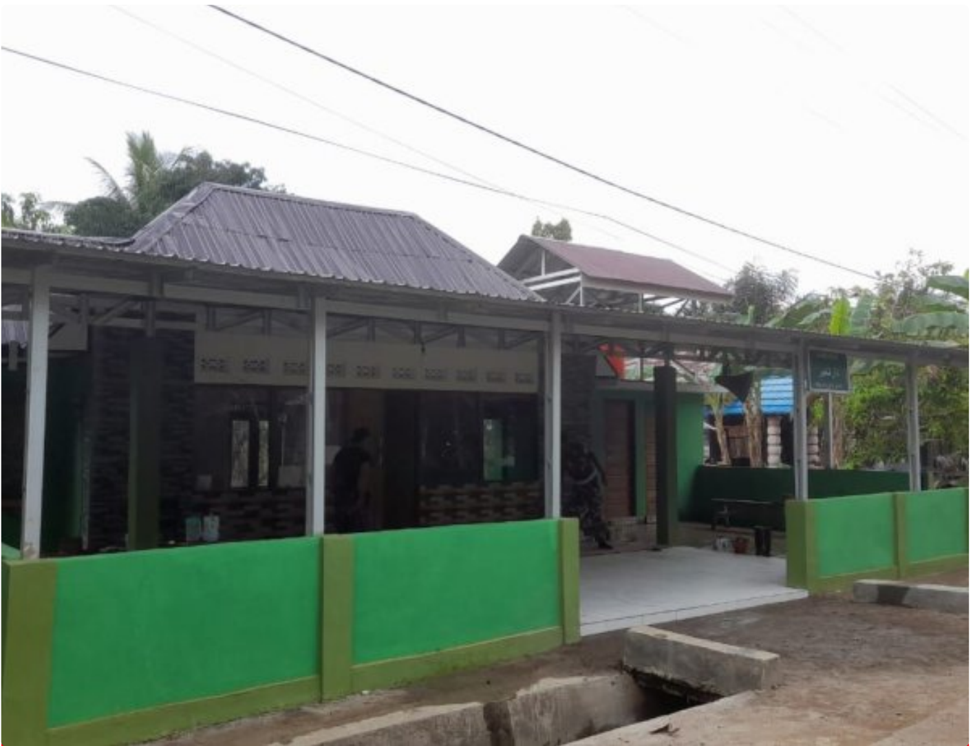
TMMD ke-116 Kodim HST Rampungan Rehab Darul Khair
