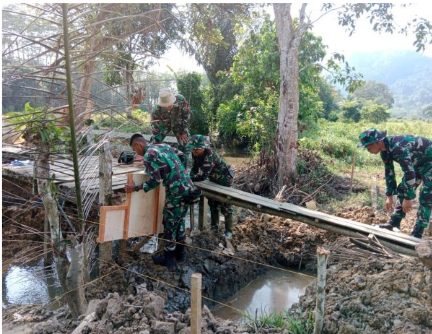
Satgas TMMMD ke-116 Kodim 1002/HST Dikerjakan Jembatan
