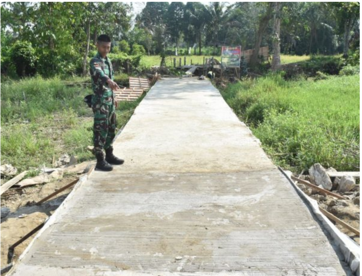
Gorong-gorong dan Slop Beton Rampung Seratus Persen
